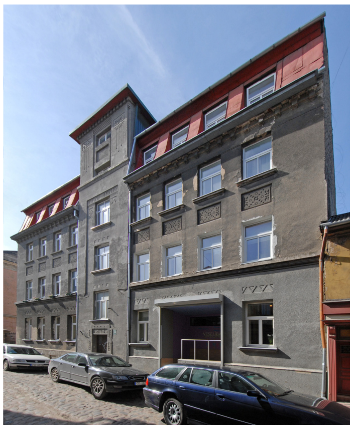
Fig. 23. Apartment house at Krišjāņa Valdemāra ielā 18. A photo taken in 2012
