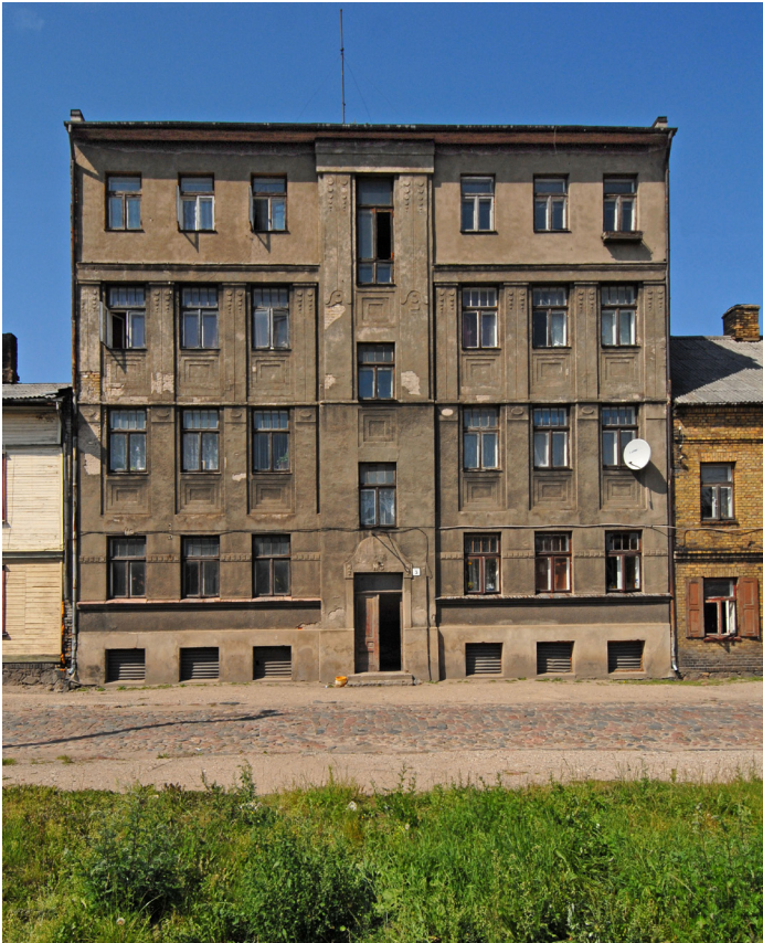
Fig. 28. Apartment house at Ferdinanda Grīniņa iela 3
