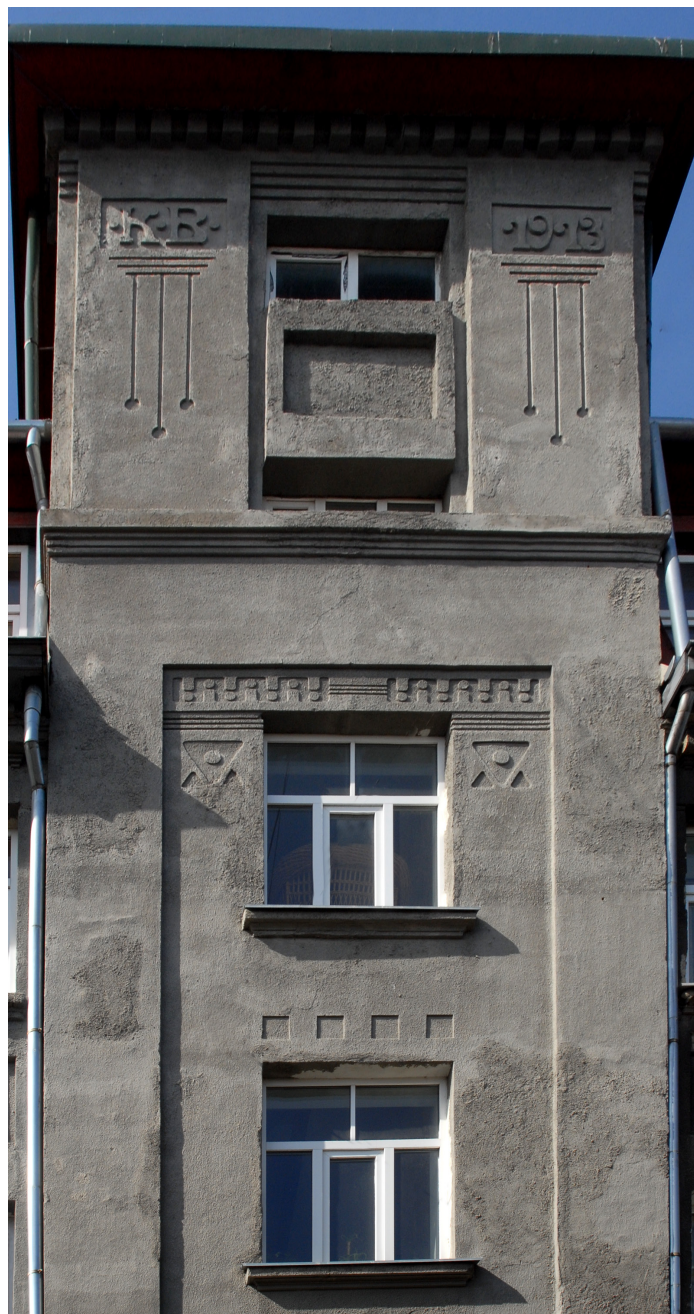
Fig. 24. Apartment house at Krišjāņa Valdemāra ielā 18. A fragment of the façade
