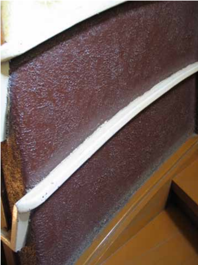
Fig. 17. Fragment of staircase wall. Mansion at Strēlnieku iela 2, Ogre. 1935(?). Teodors Hermanovskis. [7].
